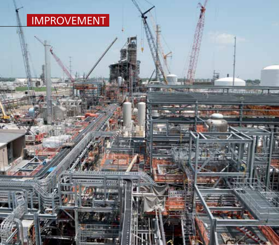
Установка аммиака в Дональдсонвилле (США), с мощностью по аммиаку 3300 тонн в сутки и по карбамиду 3500 тонн в сутки, — третья в мире установка мощностью свыше 1 млн т аммиака в год.
