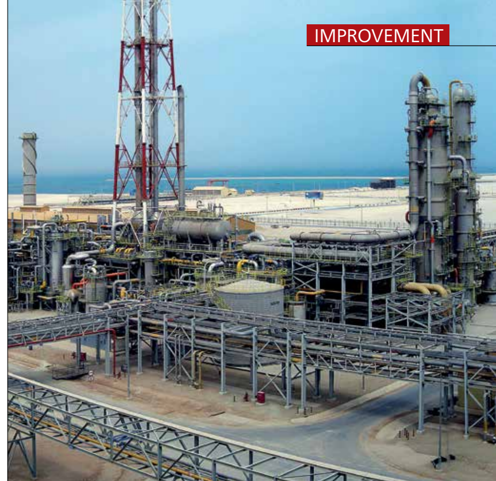
Установка аммиака компании Ma'aden (Саудовская Аравия) мощностью 3300 тонн в сутки.
