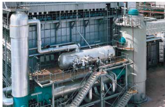
Реактор вторичного риформинга и система охлаждения технологического газа
