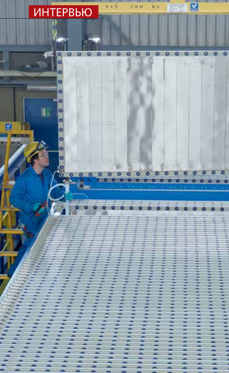
Монтаж установки электролиза thyssenkrupp.
